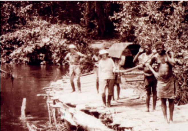
Figure 14 - Franchissement d'un marigot
