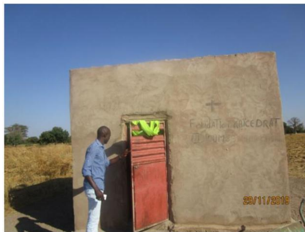
Case de santé en cours de réfection
