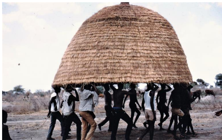
La construction d'une case, Extrême-Nord du Cameroun (© Christian Duriez)
