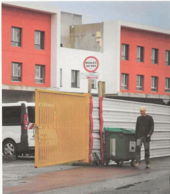
Cette semaine à Talence, sur le chantier des urgences du futur ex-regroupement Bahia, dont l'ouverture reste prévue en 2025. LAURENT THIBLET / SO
