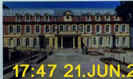
Sur le chantier du nouvel hôpital de Bagatelle, à Talence, qui abriterait à l'automne les urgences des armées. La Fondation Bagatelle a obtenu le permis de construire en 2016. (Sud-Ouest)
