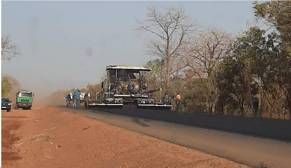
Réfection de la route Tambacounda Bala
