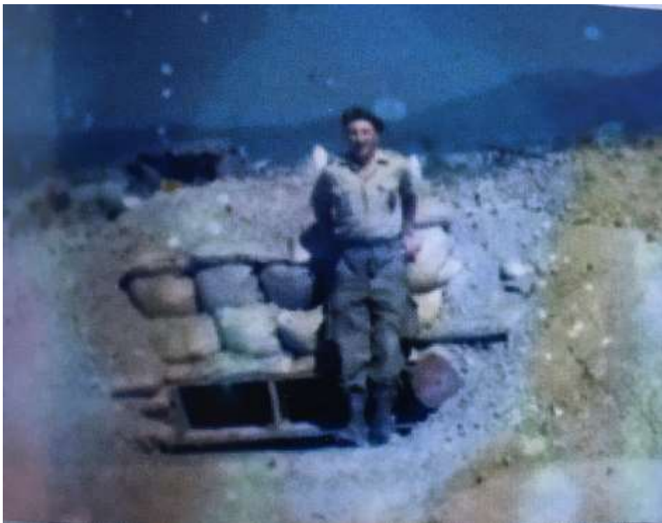
Devant son infirmerie, une des rares constructions du camp qui résistera au bombardement vietminh.
