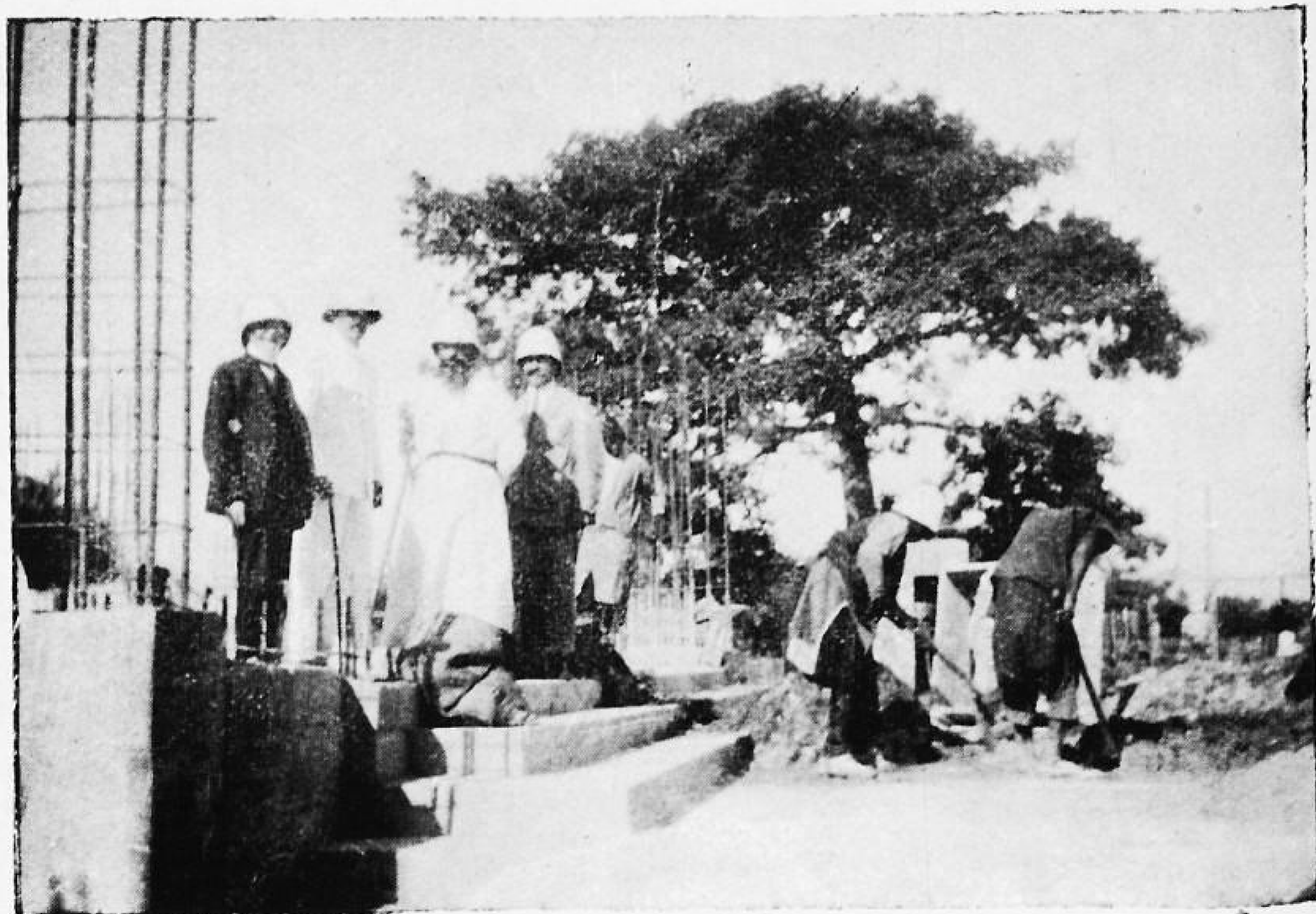
DAKAR : MGR LE HUNSEC VISITE LES TRAVAUX
